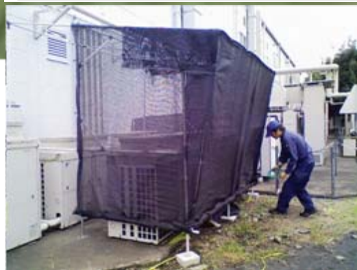
よしず設置と設置なしで比較した図 設置した場合、外気温が高いのに 電力消費量が抑えられています
