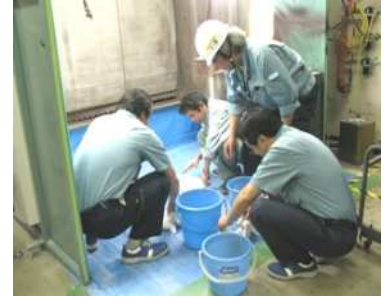
2008年度3月 塗装ブース水漏れ
