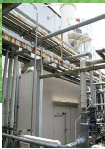
Vベルト更新した排水処理施設の設備
