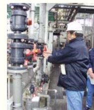
地震発生発令をうけ施設のピットの切替する様子
